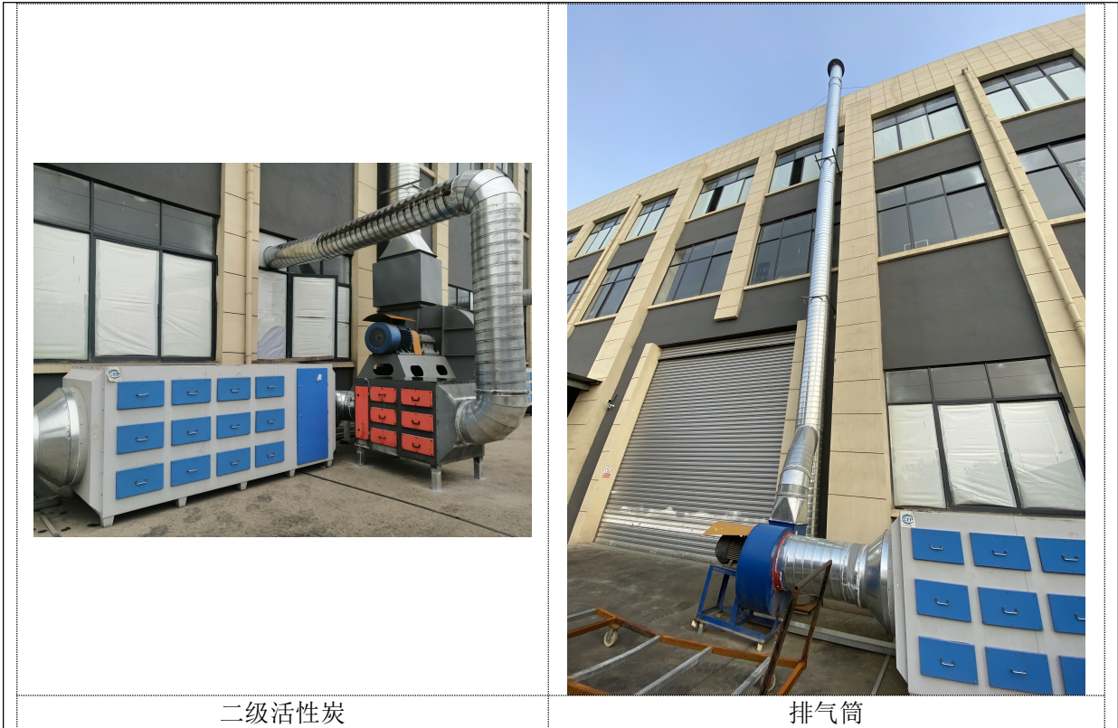
图 2 废气处理设施现场照片
