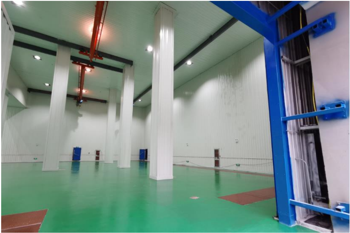
图 3-2 高电压与绝缘实验室大厅内采取的隔声和屏蔽降噪措施
