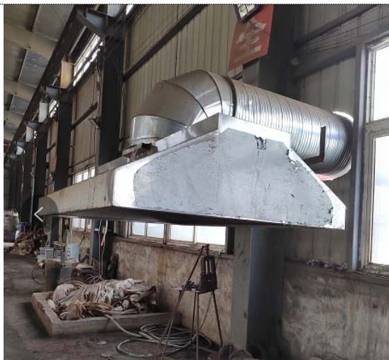
图 10 变频感应炉废气处理设施现场照片（1#排气筒）
