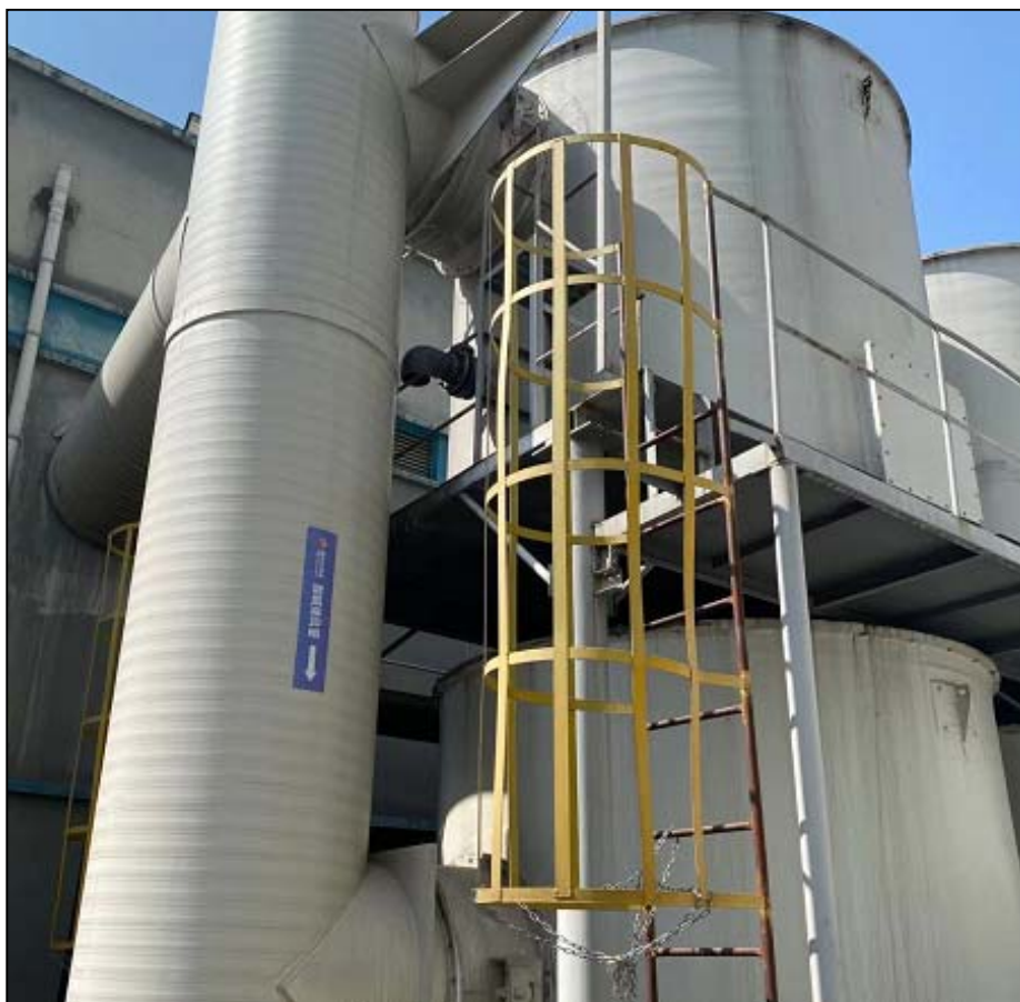
图 15 通威太阳能 SDG 干式吸附塔
