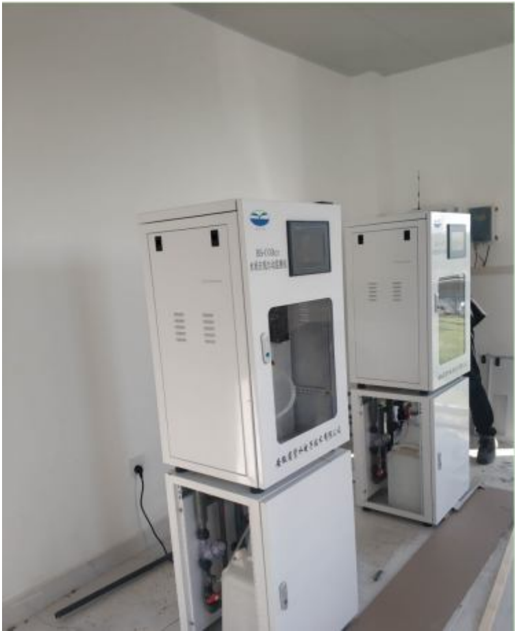
废水在线监测系统现场照片
