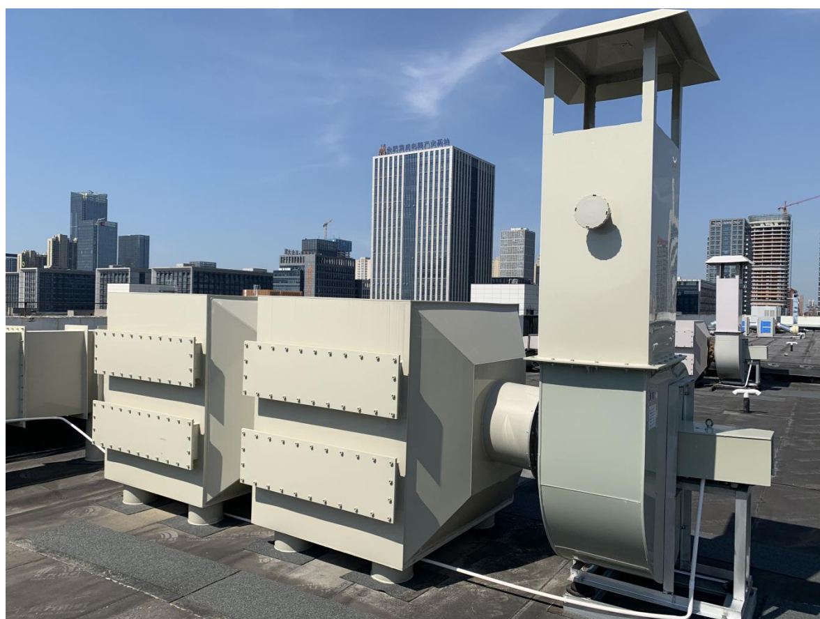
SDG 固态酸气吸附剂+一级活性炭吸附及 27m 高排气筒 (DA001)
