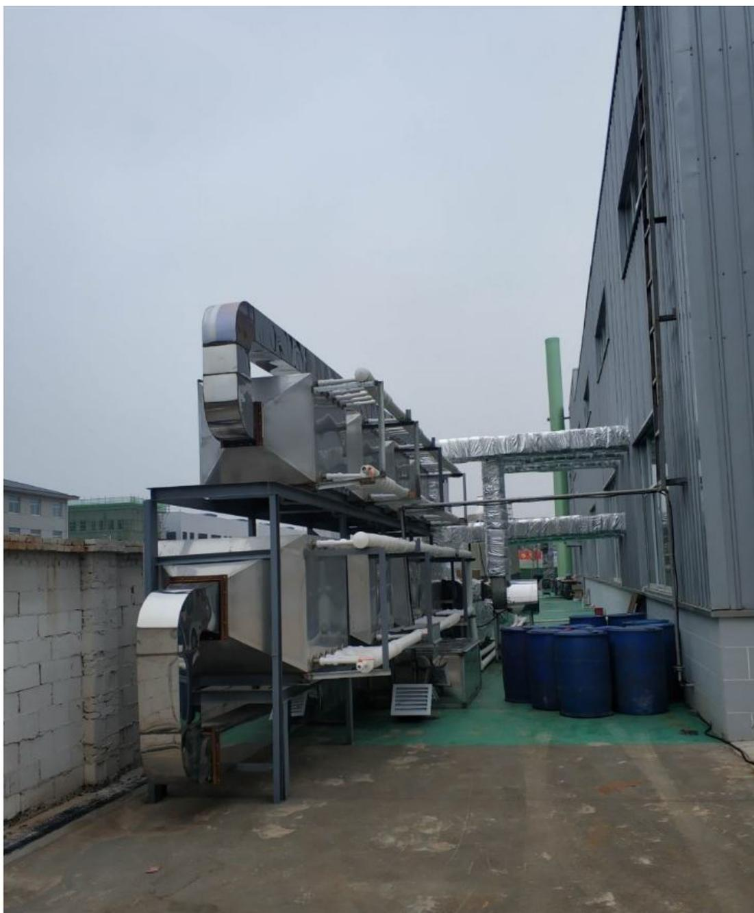
废气处理装置现场照片
