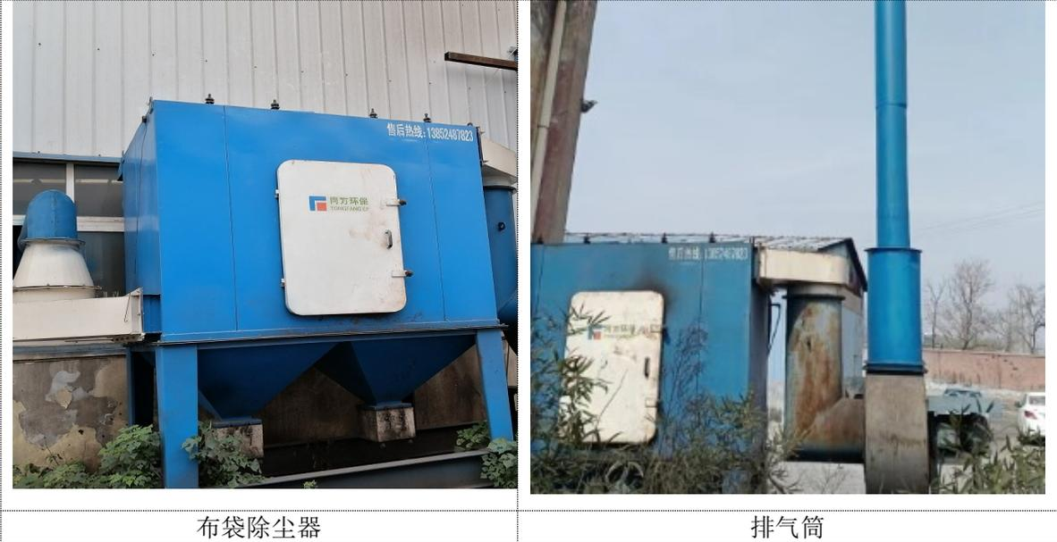
图 5 堆焊废气处理设施现场照片（1#排气筒）
