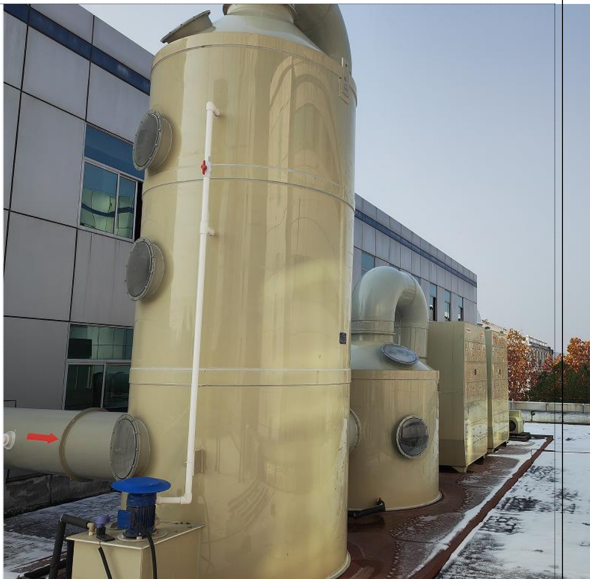
图 3-2 污水处理站废气处理设施图
