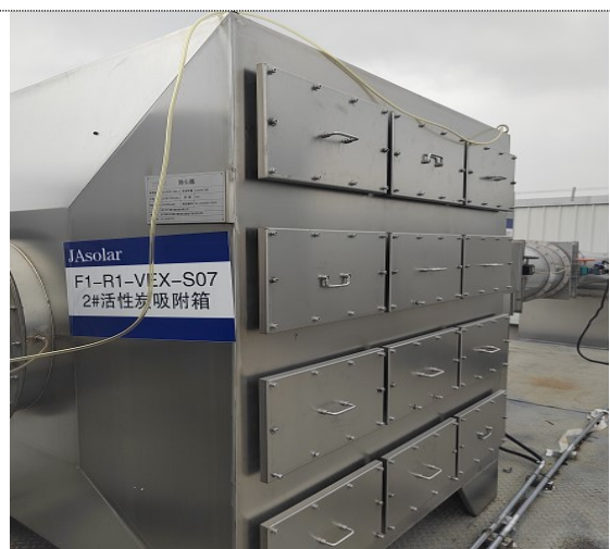
接线盒焊接、固化废气-二级活性炭吸附
