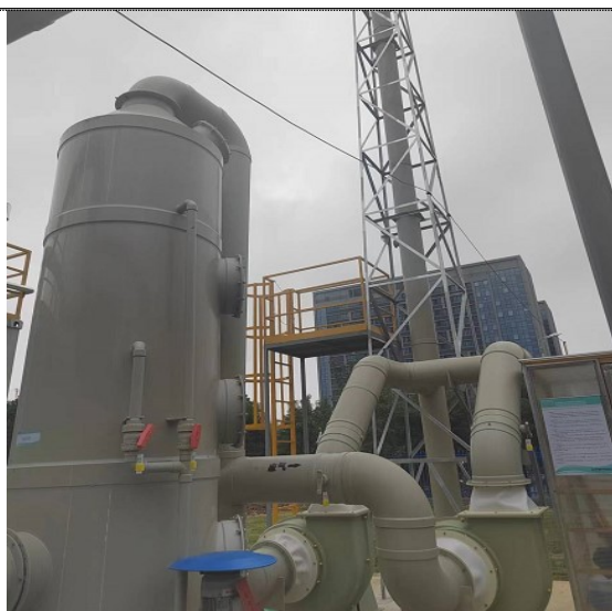
污水处理站废气碱喷淋装置
