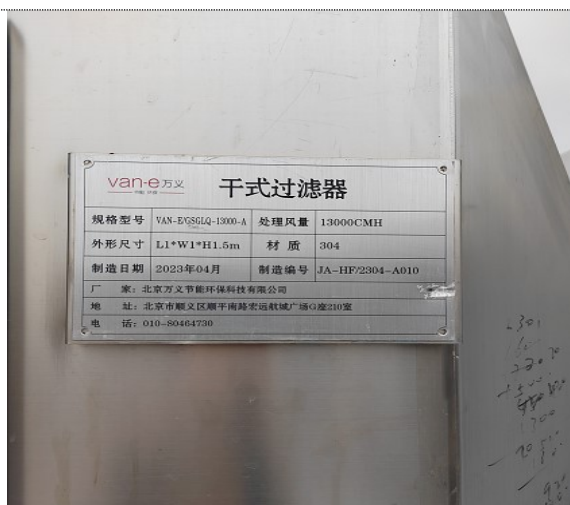
接线盒焊接、固化废气-干式过滤器
