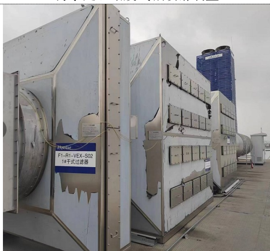
划焊废气-干式过滤+二级活性炭吸附（2套）
