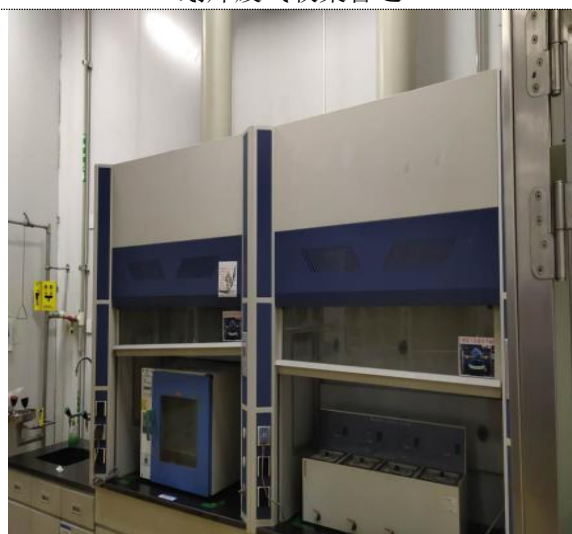
实验室废气-通风橱收集
