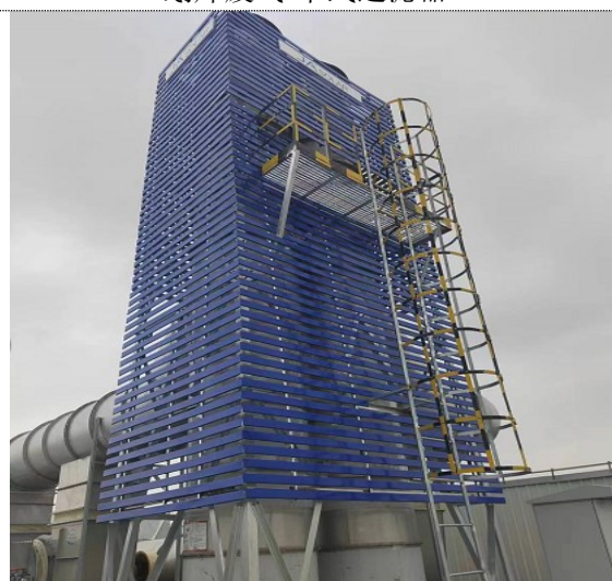
划焊废气排气筒（DA025/DA026）
