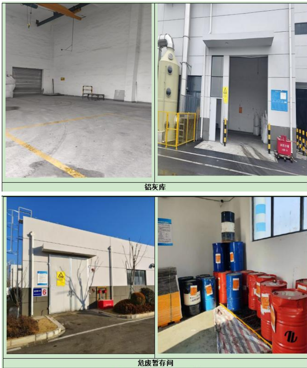
图 4.1-6 项目铝灰库和危废暂存间
